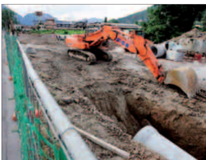
I cantieri nella zona sud della città partiranno l'estate prossima
